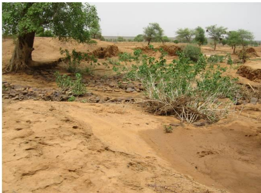
Photo 5: Rupture de la digue de protection du périmètre
