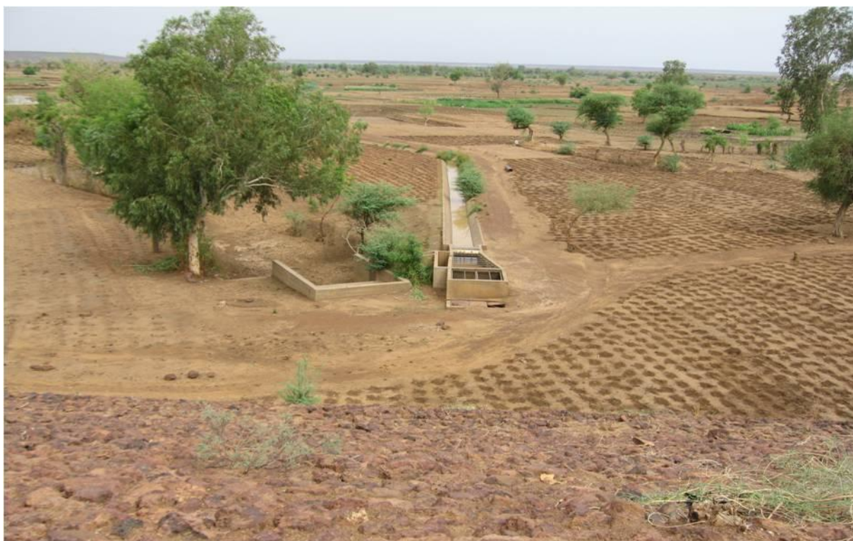
Photo 2: Ouvrages d'irrigation gravitaire
