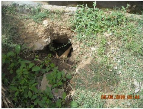
Figure 4: Déchaussement et fuites sur les canaux au GN01
