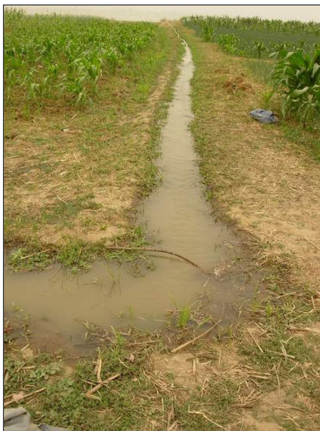
Photo b. Canal d'irrigation alimenté par un groupe motopompe (Luc, J.Ph. 2006)
